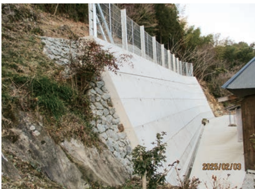
〈がけ崩れ防止工事〉
