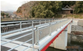
〈弓瀧橋歩道工事〉
