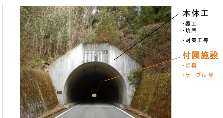
図 2.1 トンネル構造
