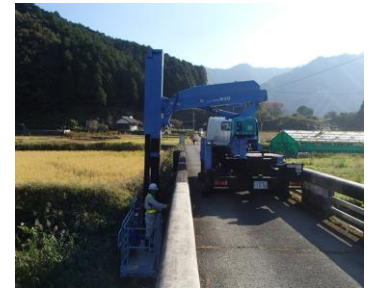
橋梁点検車による定期点検
