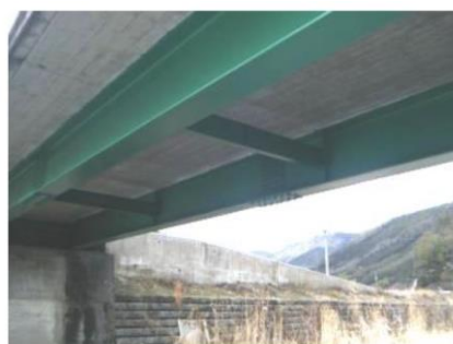
久保川橋（鋼桁塗装）
