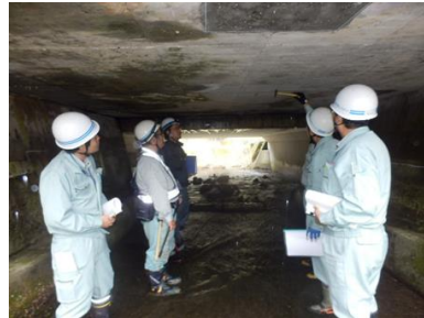
損傷・変状確認
