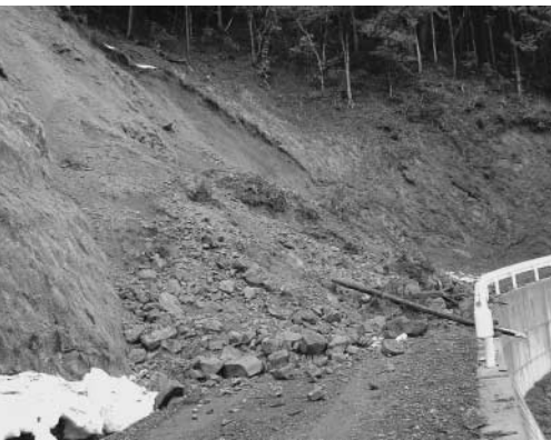
■土砂崩れにより寸断された林道（北川地区）
