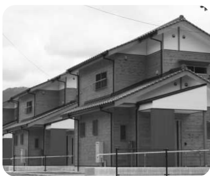
公営住宅の建設
