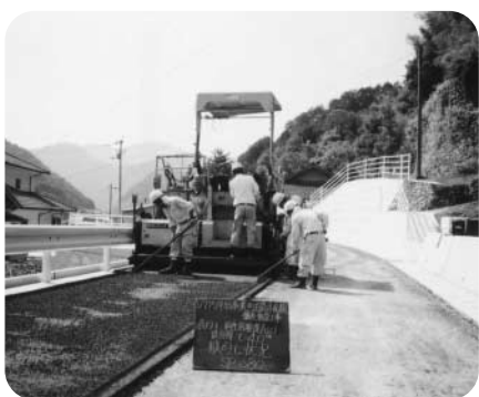
道路改良・整備
