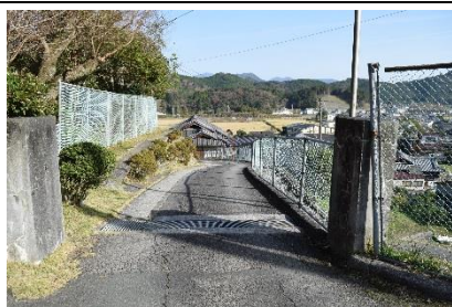
北側の接続道路
