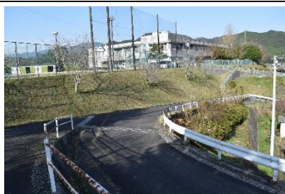
南側の接続道路
