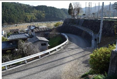
北側の接続道路
