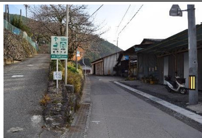
進入路への接続道路の急カーブ
