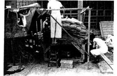
全測定は載荷各段階毎に行つた。これはストレンゲージの係による電気抵抗の変化とストレンゲージの読みから、水による測定差の分が算出される。又同時にダイヤルゲージによる変位及び変位の測定及び亀裂の発生、その方向も観察した。
