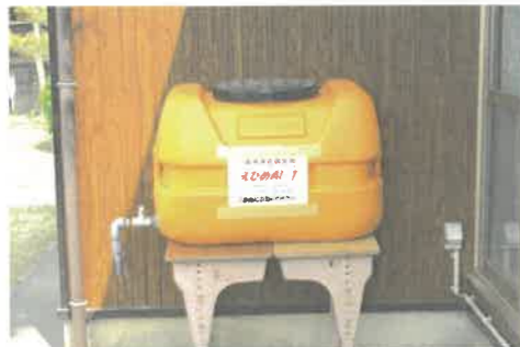
200リットルタンク設置
