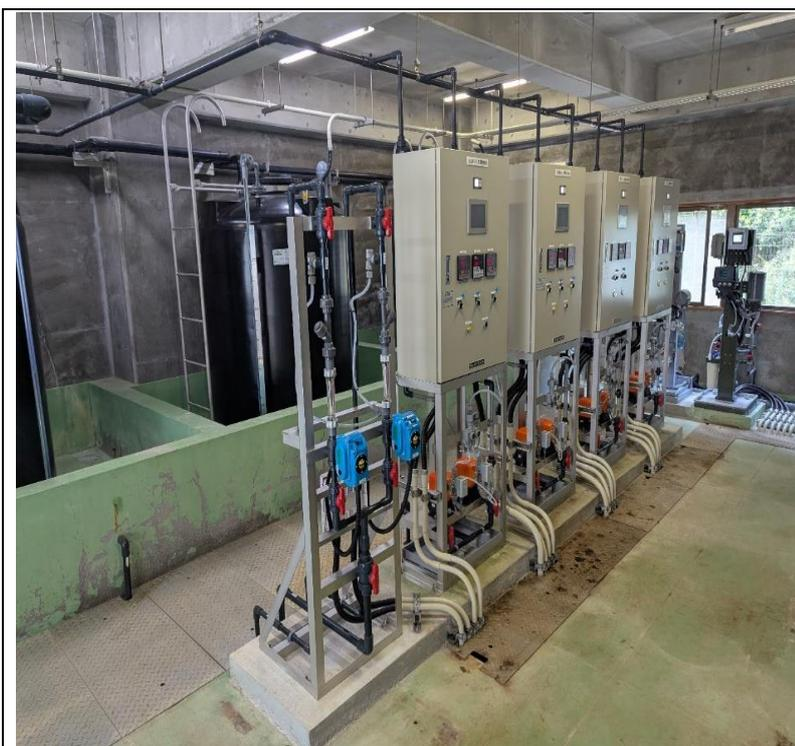
この写真は令和6年度に更新整備した大藤浄水場の薬品を注入する設備です。③の凝集沈殿させるための薬品や④の塩素を注入・調整する機械です。安全でおいしい水を提供するため随時機械の更新も行っています。
