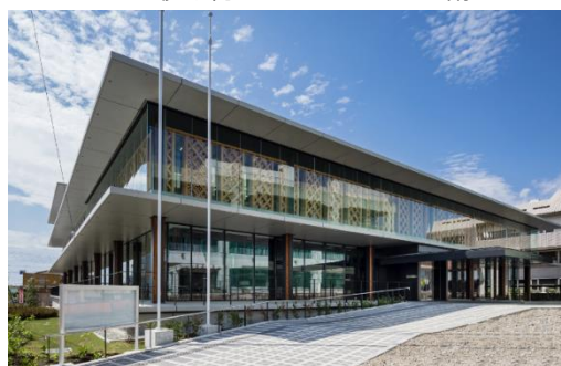
図 3-5-5 神奈川県足柄郡開成町庁舎に おける ZEB 事例 出典:松田平田設計 HP
