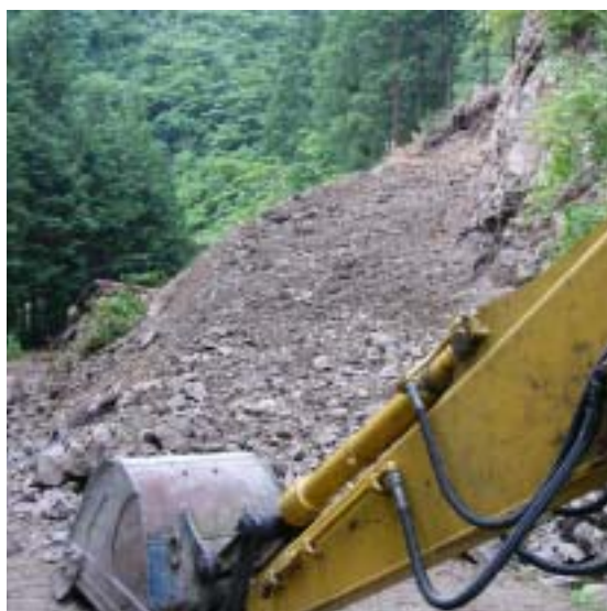
戸祇山下の林道終点手前。町の重機が入り、まずは入口部分の工事が始まった。
