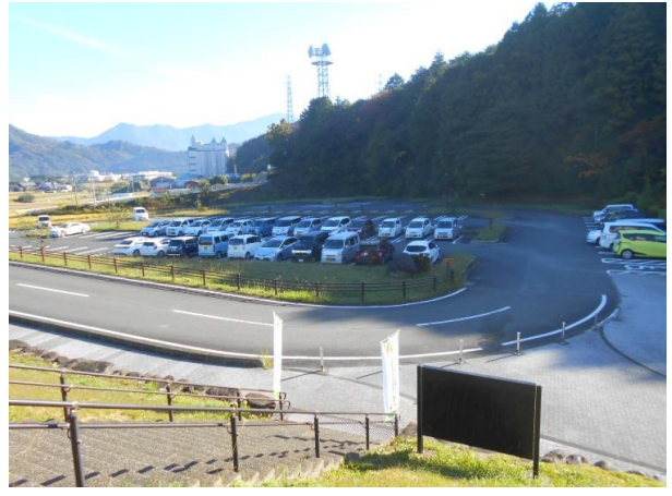
駐車場（第1駐車場）
