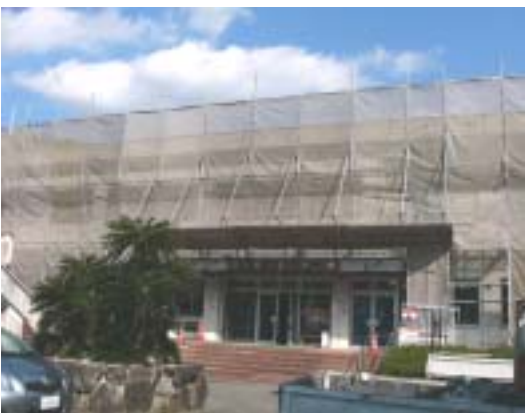
足場が組み立てられ防塵ネットに覆われた三島公民館。ネット撤去時には、お色直しが終わり、入念な下地処理（防水）と化粧（塗装）が施された、美しい姿がお目見えする予定です。
