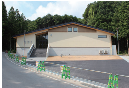
▲建設中の奈良山等妙寺歴史交流館
