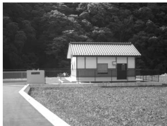
▲川口地区農業集落排水処理施設 （大字父野川下）
