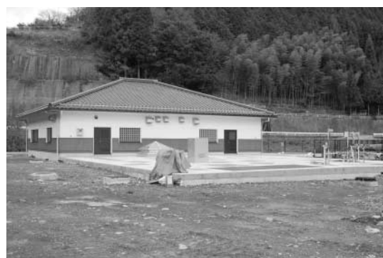
▲幸田地区農業集落排水処理施設 （大字上大野）
