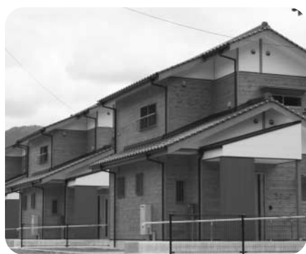
公営住宅の建設
