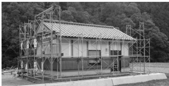
川口地区農業集落排水処理場
