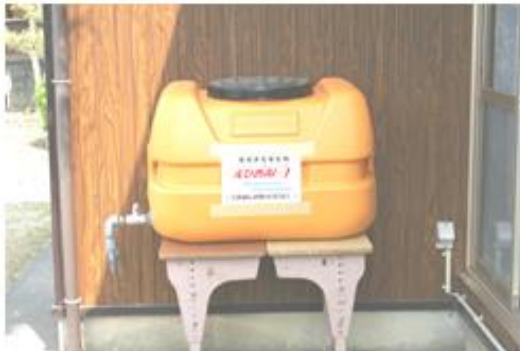
200リットルタンク設置
