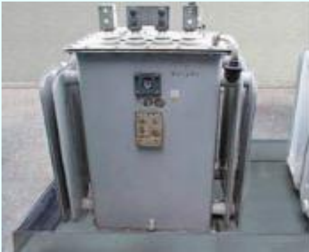
高圧トランスの例
