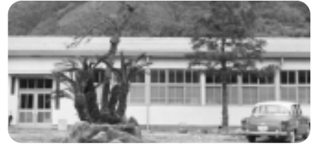
三島連絡所 昭和37年に完成
