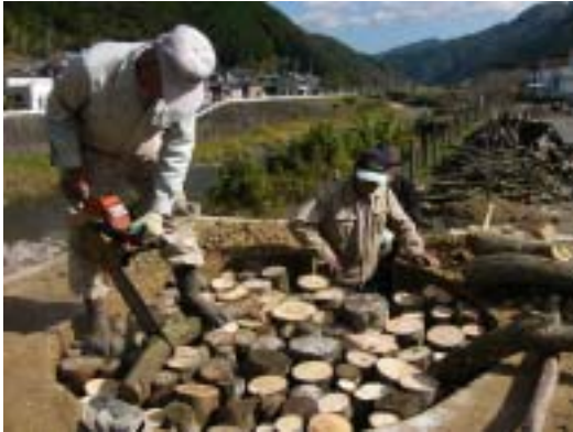
壁面が完成した窯に、材を並べる清家さんら
