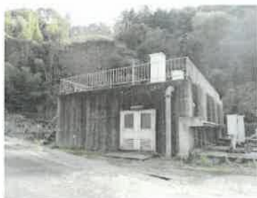
大藤浄水場（急速ろ過池）
