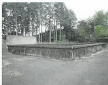
近永浄水場（緩速ろ過池）
